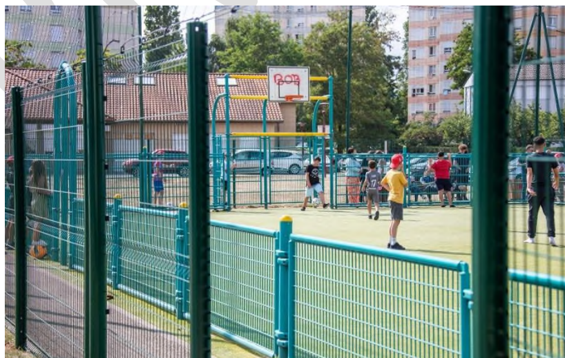
Figure 20 - Le City Stade après travaux. Source : Ville de Thionville, 2023
