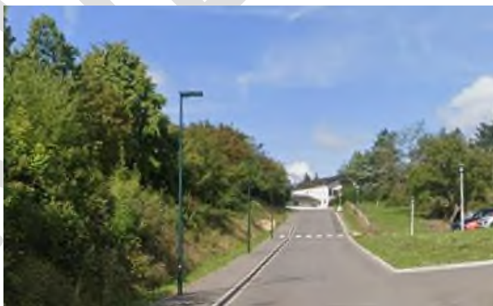
Figure 8 – APRES travaux - Désenclavement du quartier en supprimant l'impasse et création d'un parking, permettant un hôpital biface. Source : Google maps 2023
