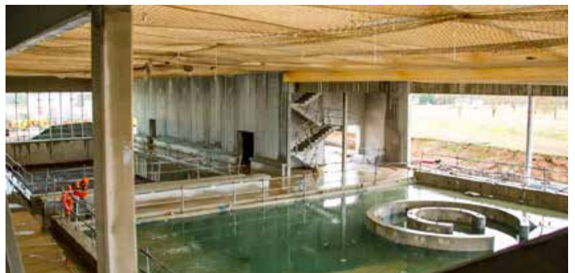
- Avancement des travaux - Janvier 2022
