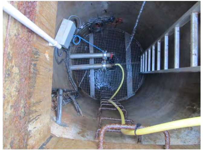
Intérieur du puits militaire avec les deux pompes
